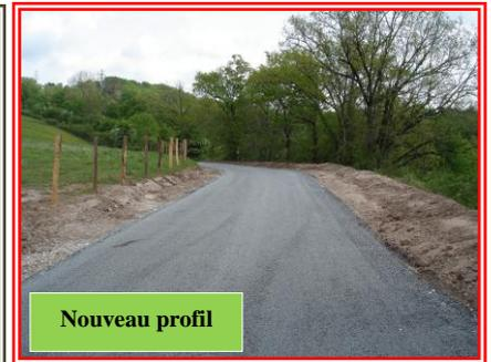
Entre ces deux zones, un enrochement a permis de renforcer la chaussée qui s'affaissait.
