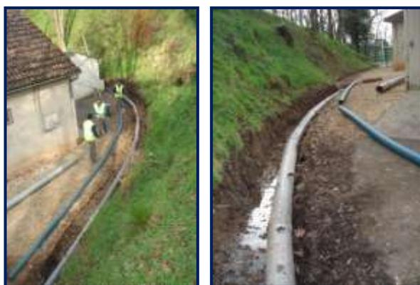
Le drainage aux abords du stade et l'évacuation des eaux pluviales ont été entièrement remplacés par les services techniques.
